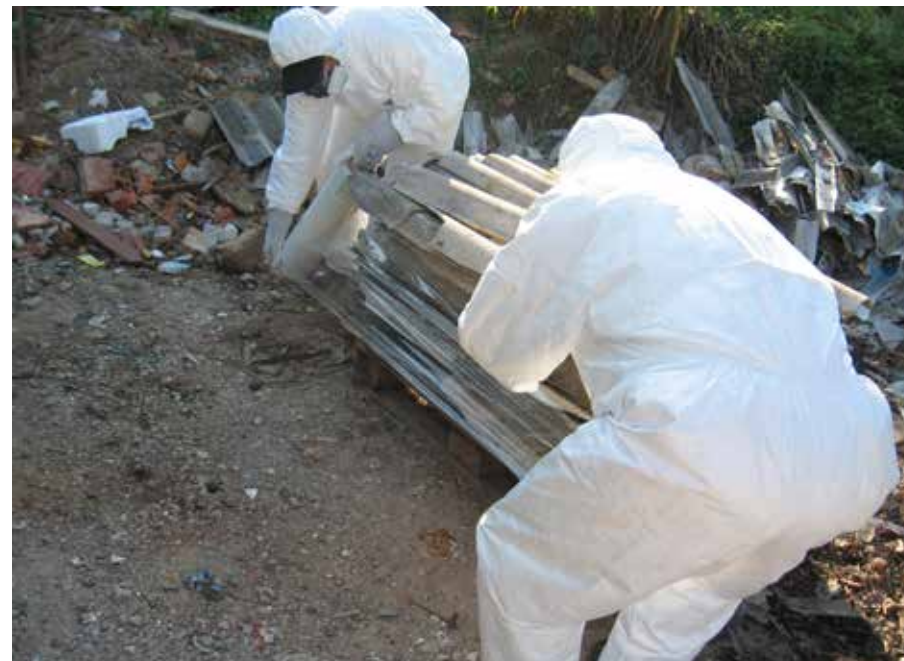
Delavci v zaščitnih oblačilih z odlagališča odstranjujejo azbestno kritino
