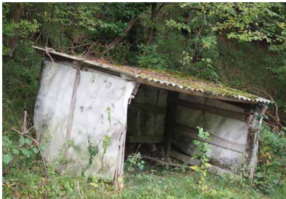
Kožbana - avtobusna čakalnica iz azbestne kritine in filca, v katerem so zapičena azbestna vlakna
