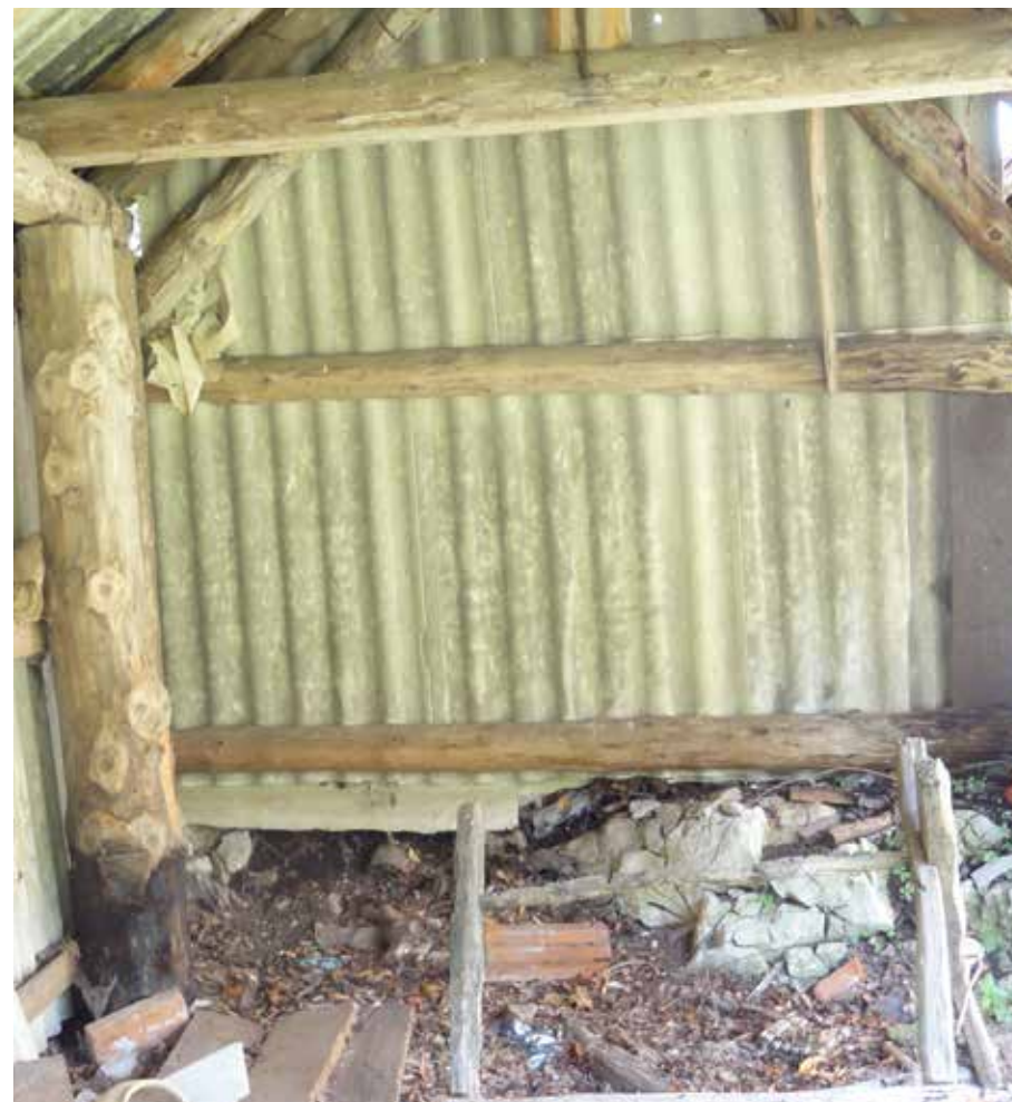
Notranjost barake, zgrajene iz azbestnih plošč
